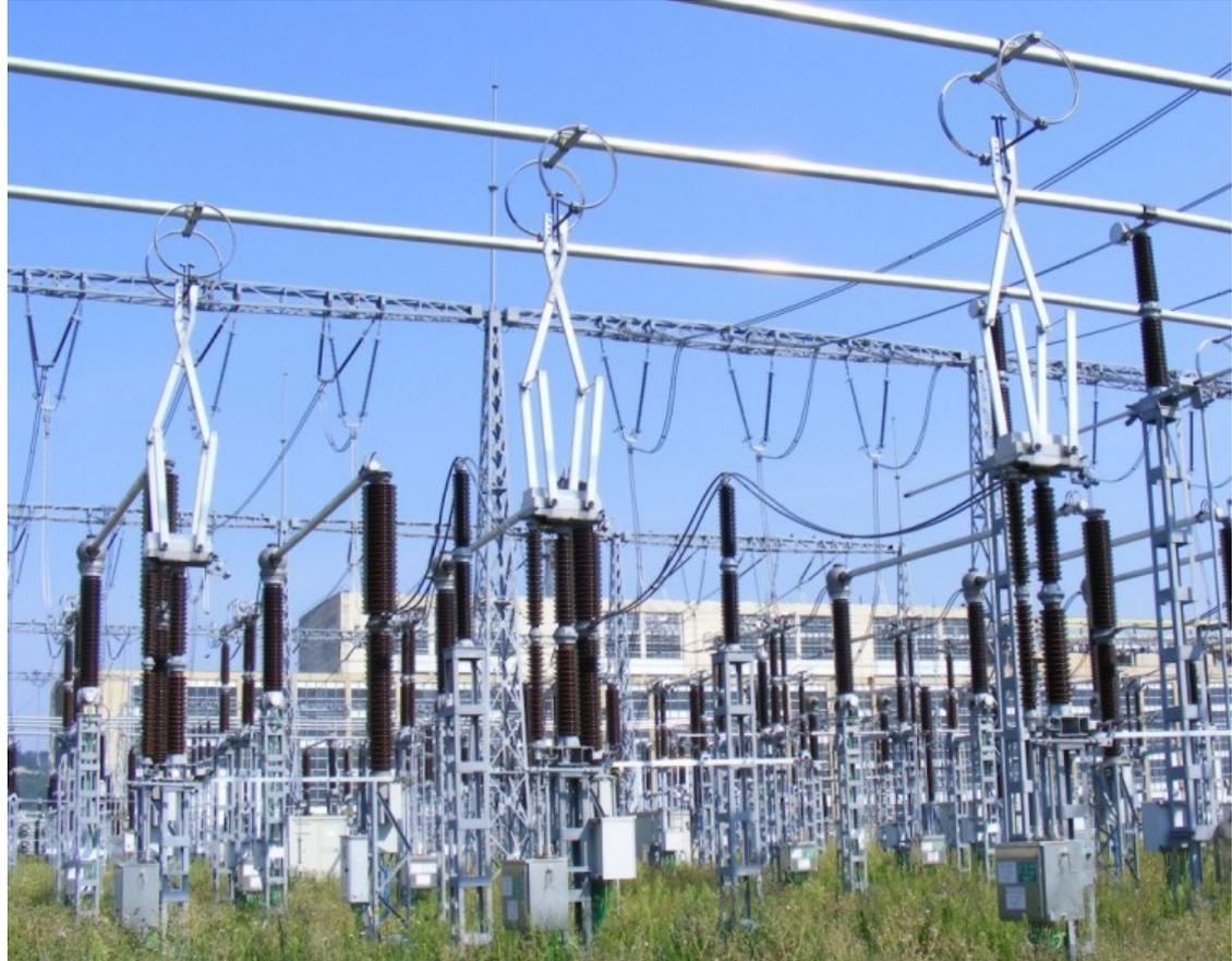
Seccionadores de pantógrafo en posición abierto y cerrado
